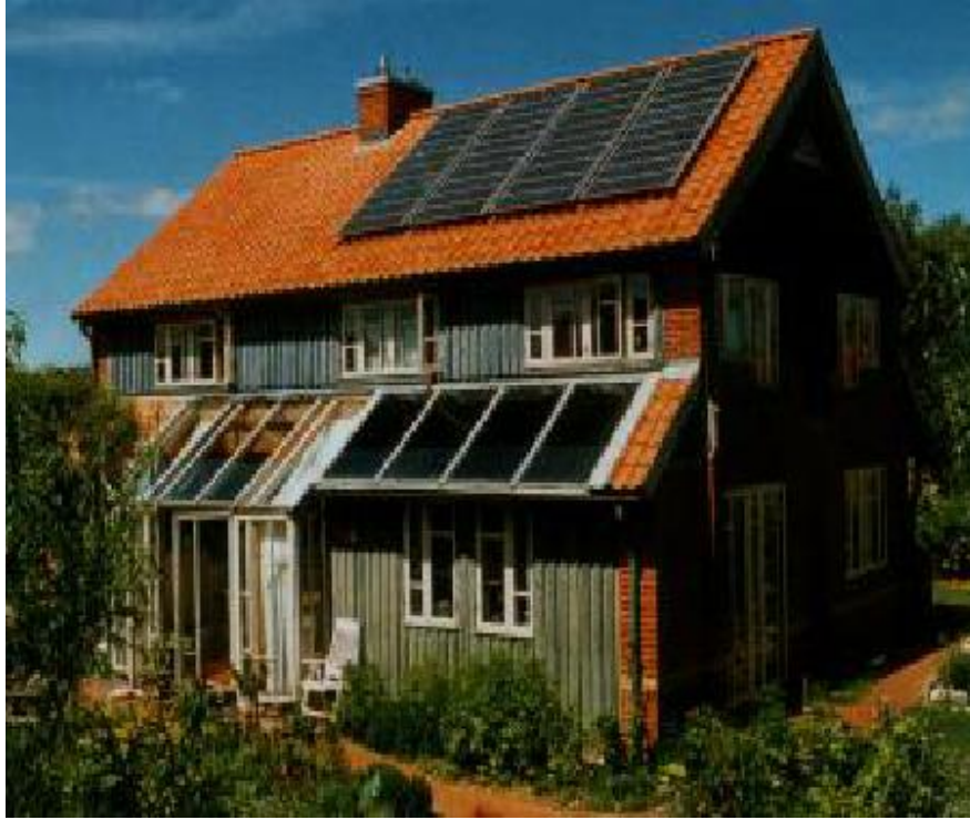
الشكل (17.4) خلايا شمسية مثبتة على سقف احد المنازل.
