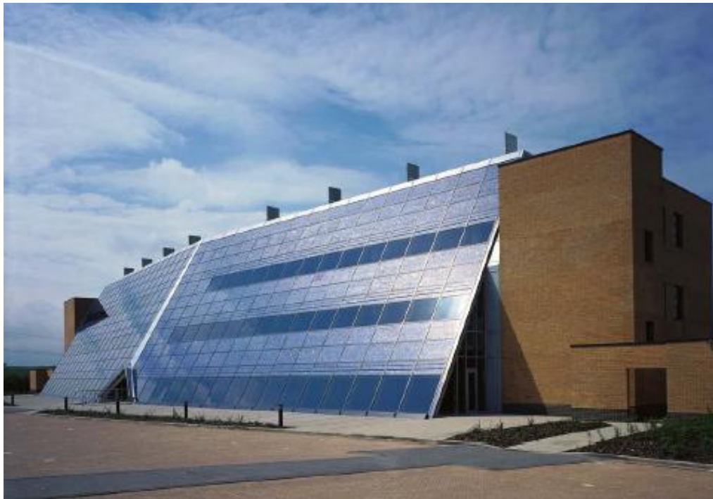
الشكل (18.4) خلايا شمسية مستخدمة لتجهيز الكهرباء لبناية كبيرة ويلاحظ التصميم المعماري المميز والمتناسق مع استخدام الطاقة الشمسية.
